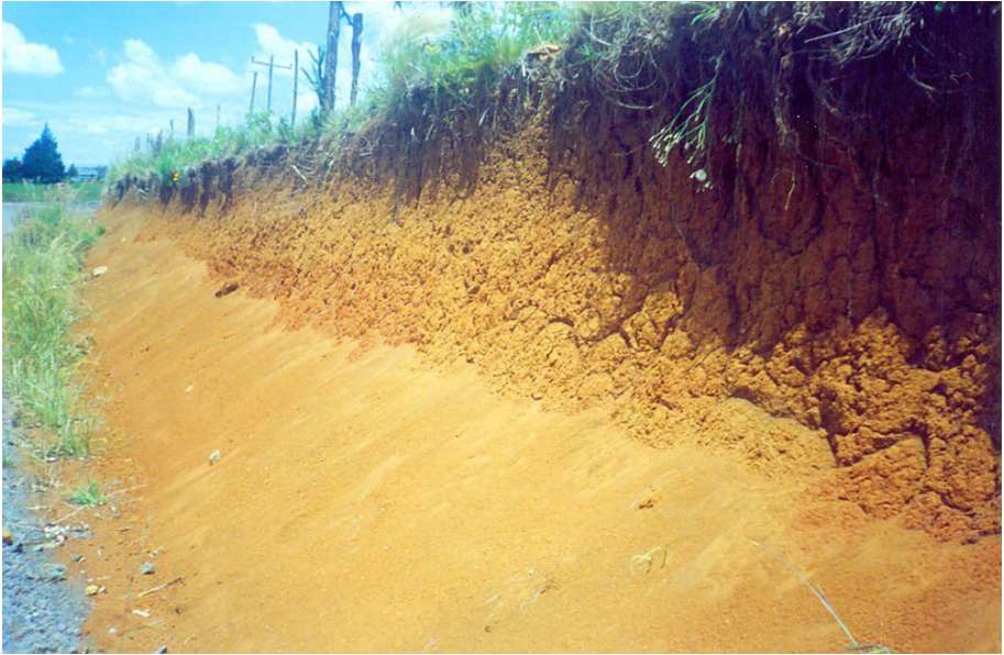
Figura 23. Corte de estrada em área de Latossolo Bruno (Vacaria, RS).
